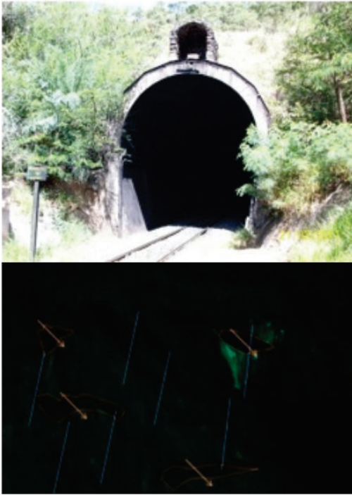
Figura 6: Túnel 2 - Sabará – Foliações e Fraturas
