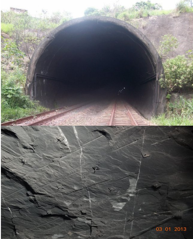
Figura 5: Túnel 1 - Nova Era - Fraturas Espaçadas
