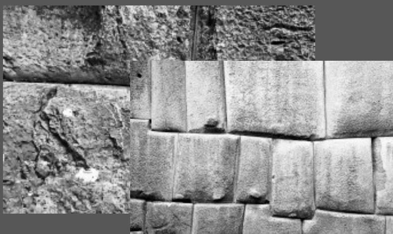
FOTO 10/11: As habilidades construtoras dos Incas eram primorosas. Lidavam com pedras gigantescas e pesadas e as uniam de forma perfeita. A exemplo dos egípcios, até hoje não se sabe como se realizou tamanha façanha. As pedras não poderiam ser cortadas por nenhum metal disponível naquela região. Por isso, especula-se que os incas dominavam uma tecnologia desconhecida hoje. Há quem diga que conheciam plantas capazes de amolecer as pedras e que assim, eles as esculpam. Há também outras teorias que estabelecem uma relação entre lendas como a dos gigantes às construções Incas, pois tais construções eram realmente muito grandes.
